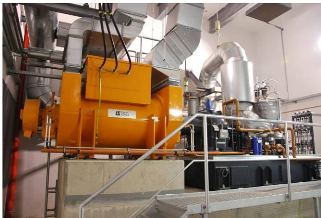
Bild 5 Gegendruck-Dampfturbinenanlage
