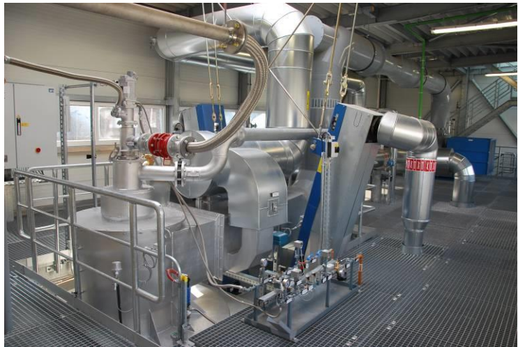
Bild 3 BKS-Brenner
