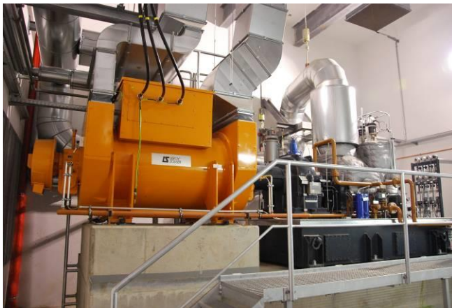
Bild 5 Gegendruck-Dampfturbinenanlage
