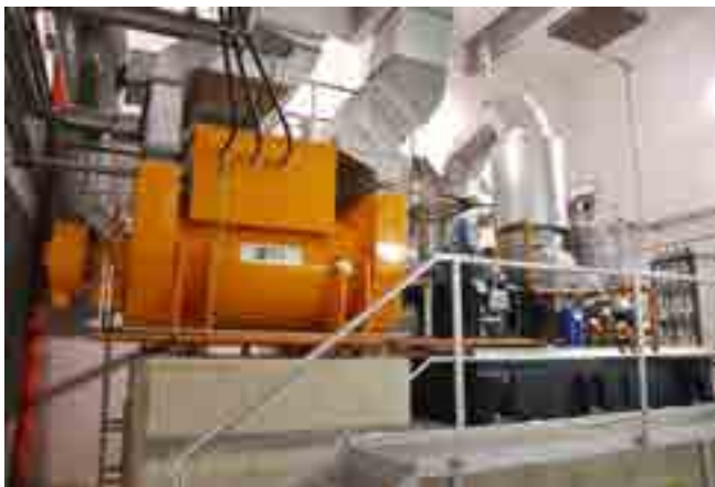
Bild 5 Gegendruck-Dampfturbinenanlage
